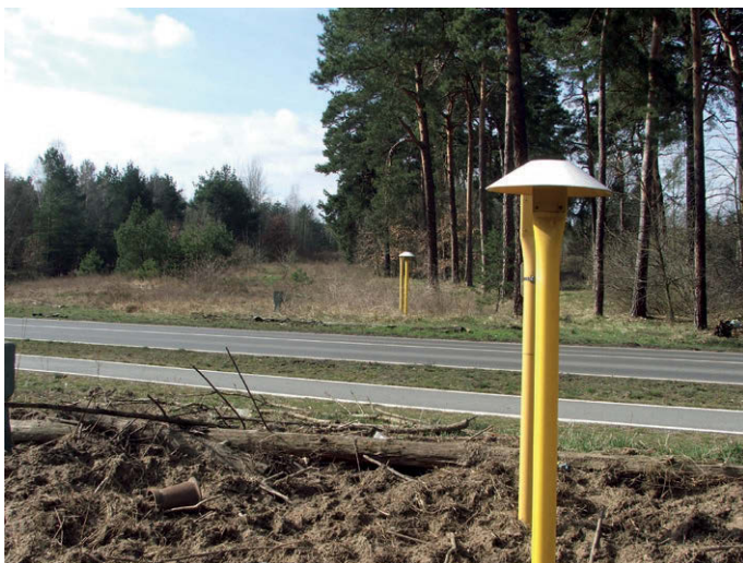
Abb. 1: Trassenmarkierung einer Erdgaspipeline bei Unterquerung einer Strasse
