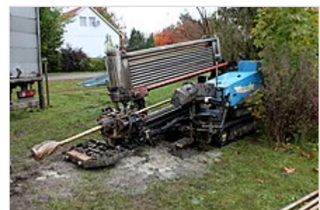
HDD-Anlage mit Backreamer
