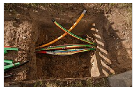
Auf freiem Feld per HDD verlegte Leerrohre für Glasfaserkabel.
