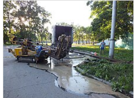
HDD-Anlage beim Rohreinzug
