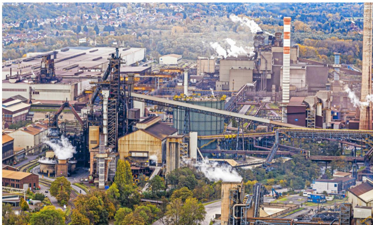
Die Dillinger Hütte: Der erste Hochofen soll in Dillingen 2030 abgeschaltet werden. Die Hochöfen und Kokerei sind überflüssig im künftigen Produktionsverfahren mit Direktreduktionsanlagen.
