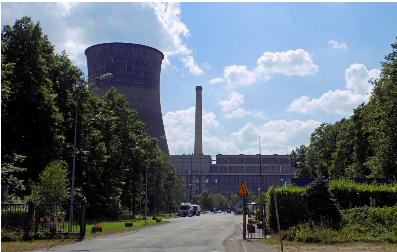
L'entrée de la centrale de Saint-Avold, en Moselle. Illustration - Jean-Marc Pascolo
