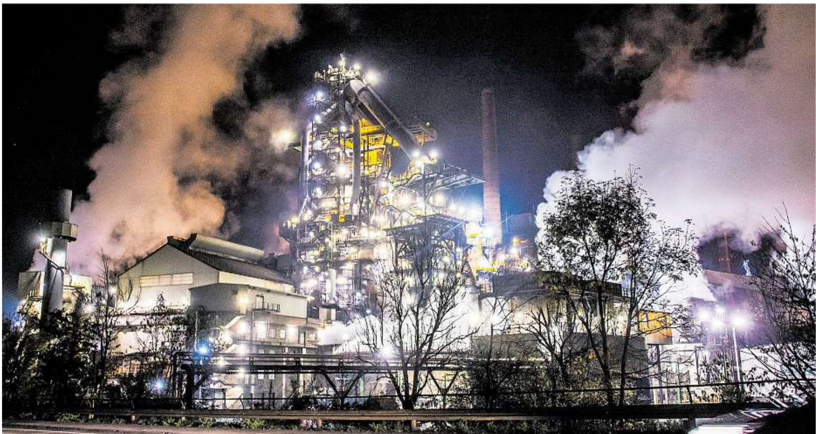
An der Dillinger Hütte ist die Transformation der saarländischen Stahlindustrie bereits im vollen Gange. Unter anderem soll hier eine Anlage zur klimafreundlichen Direktreduktion von Eisenerz mithilfe von Erdgas und/oder Wasserstoff entstehen. 140 Meter hoch wird diese neue, hochmoderne Anlage und somit das wohl höchste Gebäude im Saarland.
